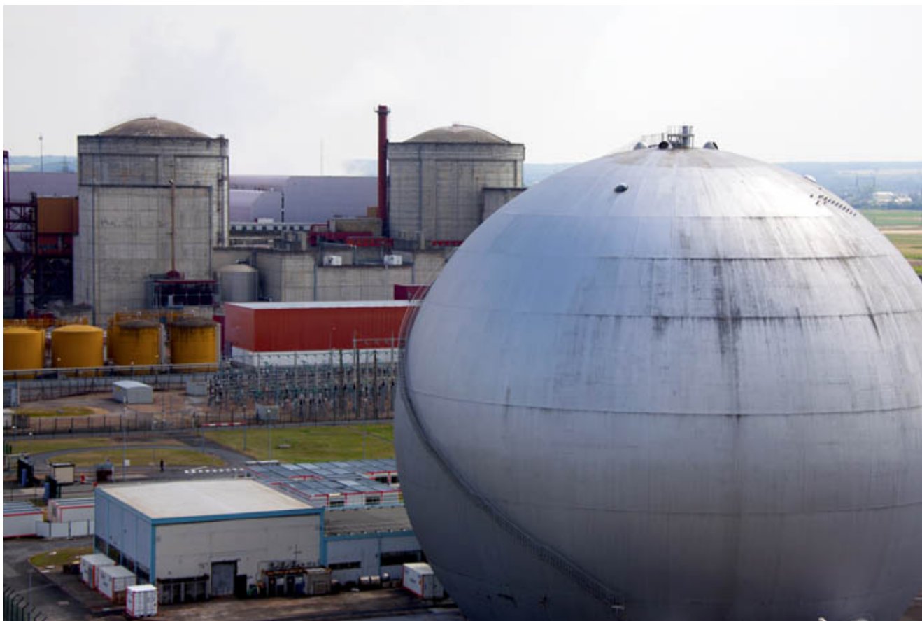
Centrale nucléaire de Chinon
