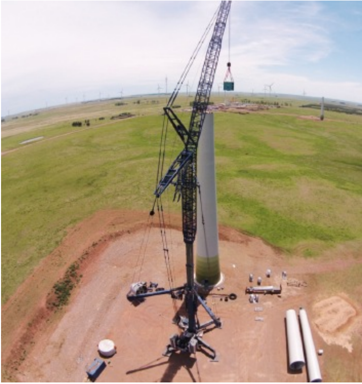
Montage du mât d'une éolienne de la centrale de Peralta.
