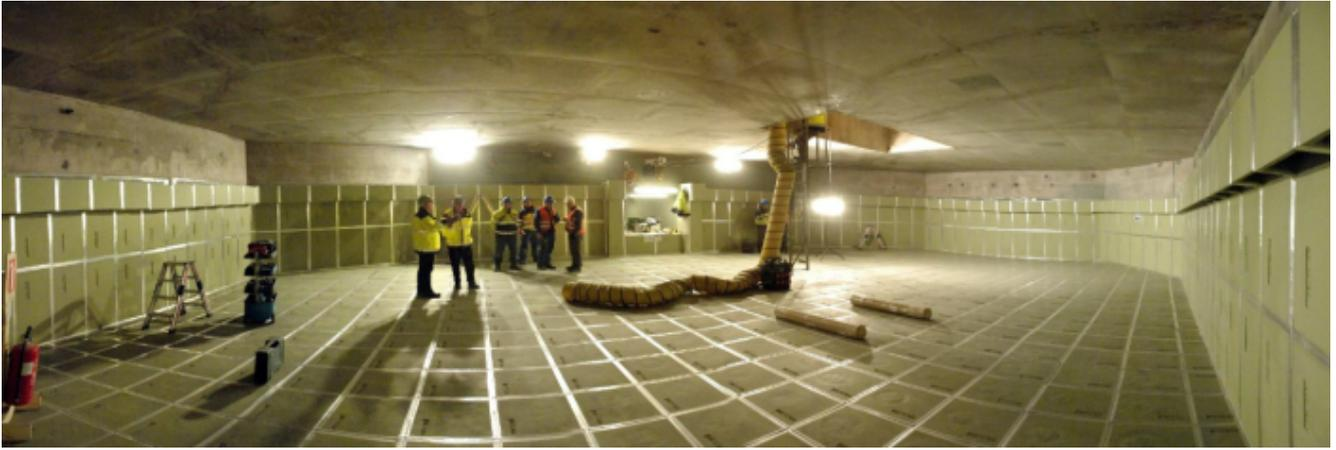
*Sur cette photo, la mise en place des briques en fonte dans la chambre de récupération du corium est achevée. Depuis, elles ont été recouvertes ensuite de béton "sacrificiel".*
