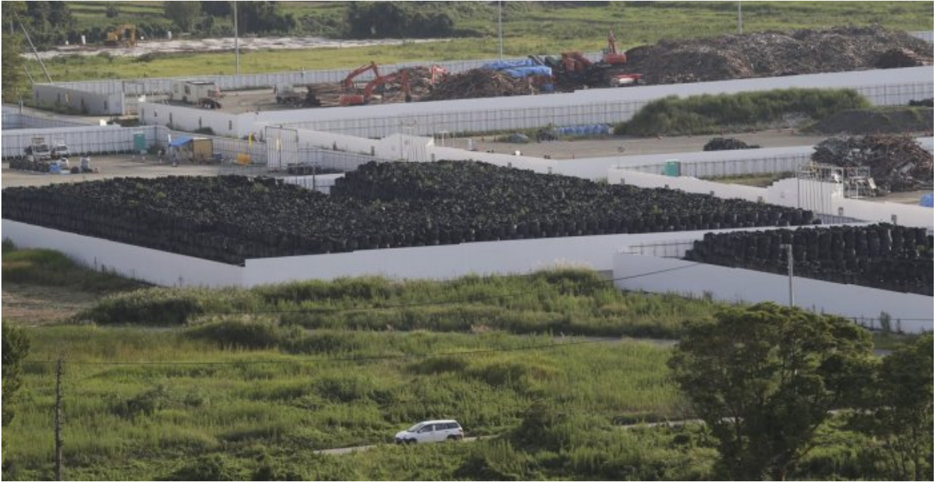
Un site de stockage de sacs de sols et déchets végétaux contaminés, non loin de la ville de Nahara dans la préfecture de Fukushima. Photo : © Koji Sasahara / AP Photo
