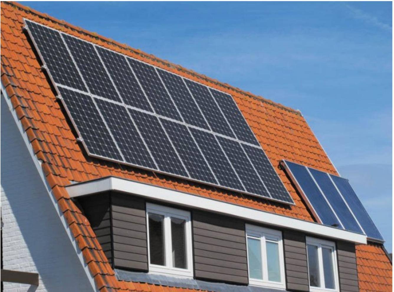
Une étude de 14 installations photovoltaïques en Allemagne, équipées en panneaux poly- et mono-cristallins, a montré une dégradation moyenne de leur efficacité de 0,1 % par an, alors que l'hypothèse habituellement retenue est celle d'une dégradation de 0,5 % par an, qui s'avère donc très pessimiste par rapport aux résultats expérimentaux ainsi obtenus. Pour l'institut, les panneaux photovoltaïques peuvent donc fonctionner pendant au moins 30 ans.
