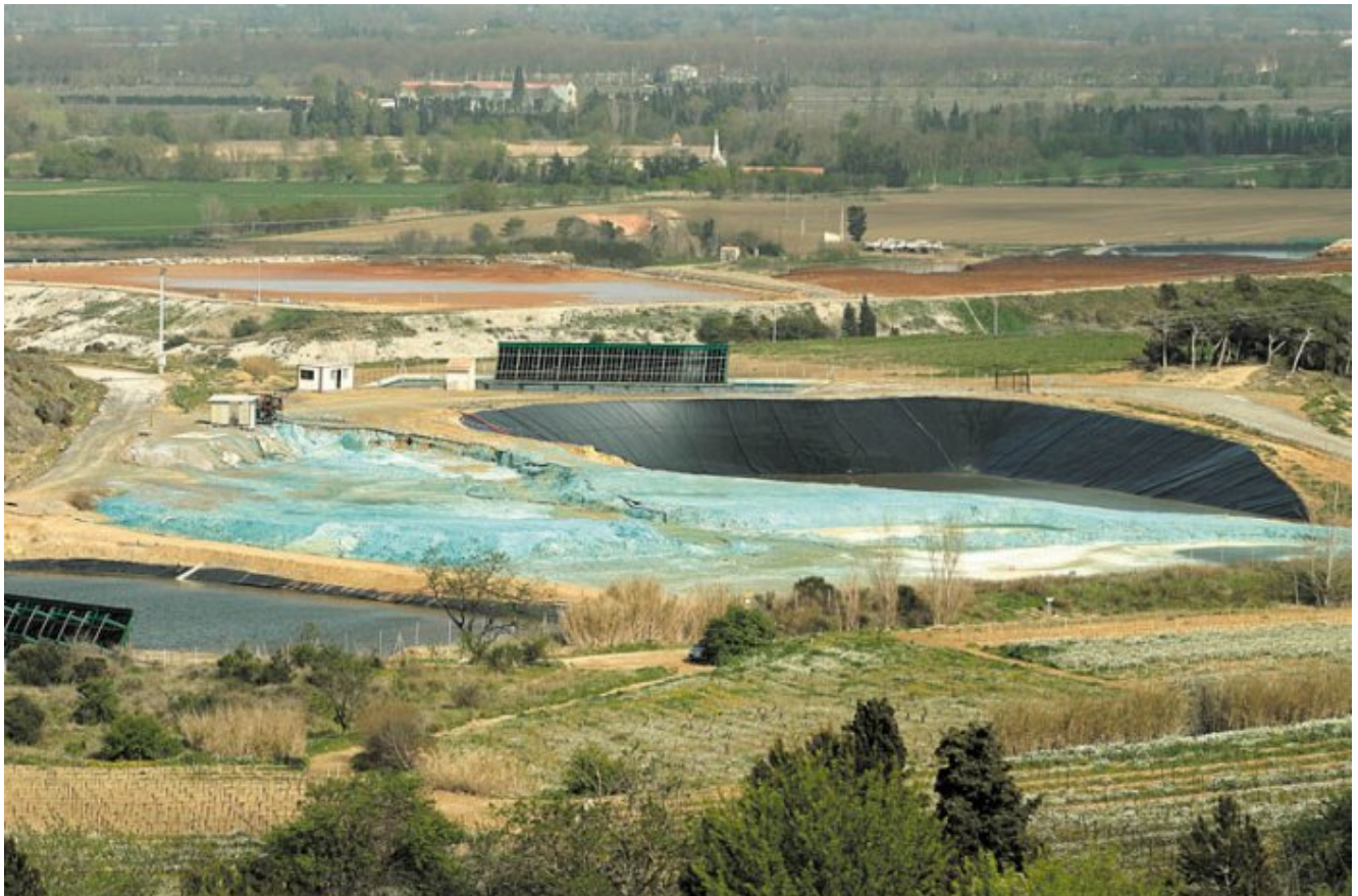
Ci-dessus, les lagunes de décantation.
