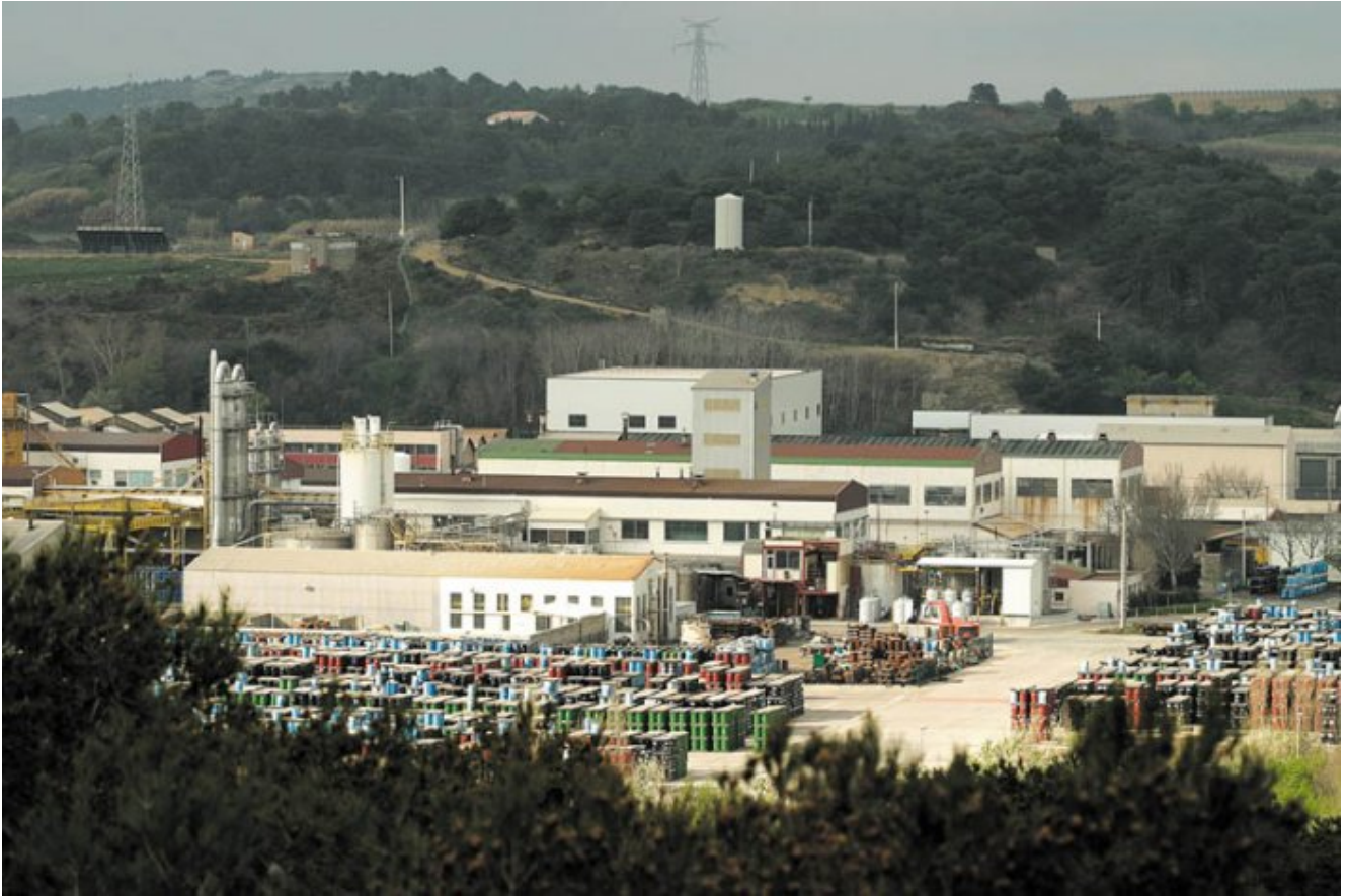
Vue générale de l'usine de Malvesi, avec le parc de stockage des fûts au premier plan.
