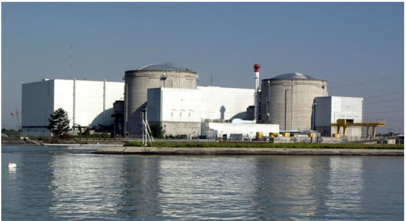
La centrale nucléaire de Fessenheim
