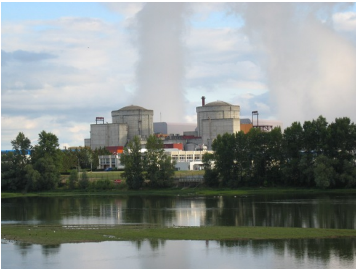
La centrale de Chinon
