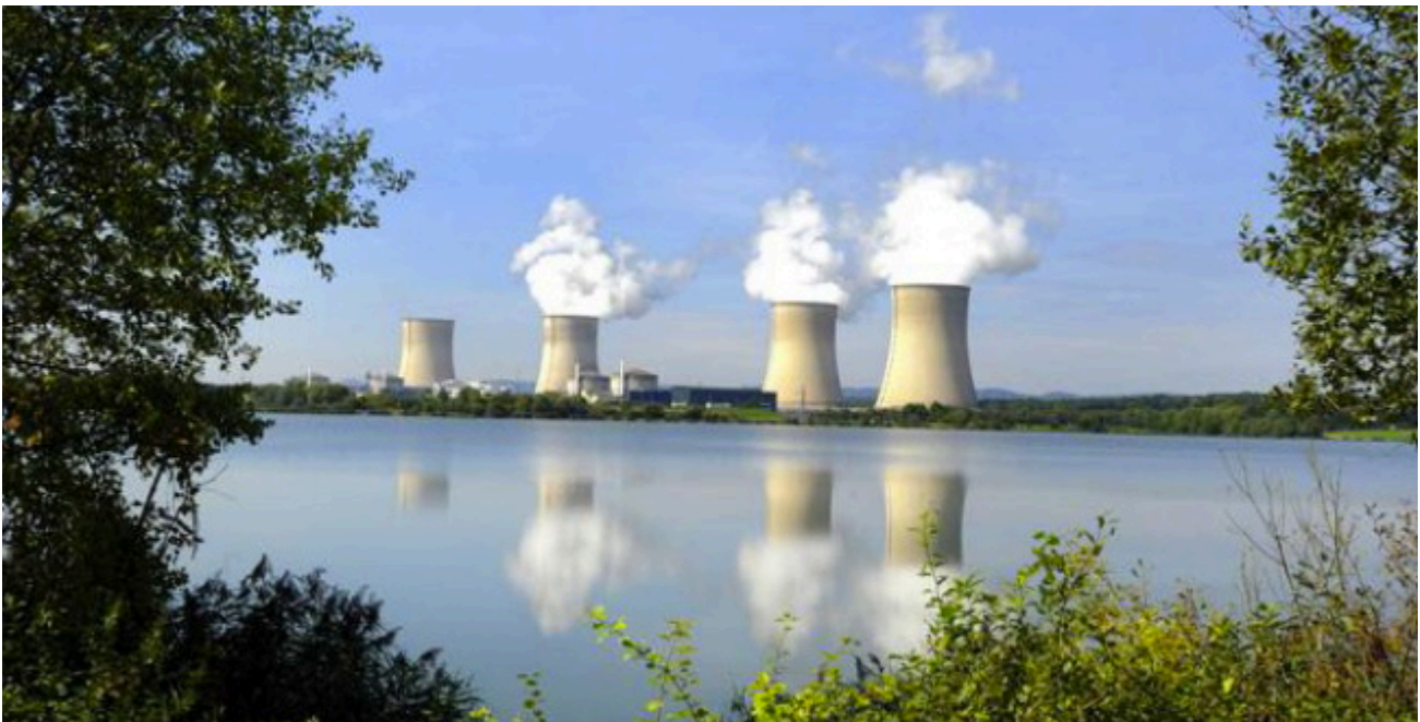
La centrale nucléaire de Cattenom, en Moselle. - SPIEGL/PHOTOWEB/SIPA
