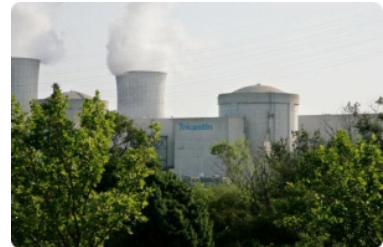
Centrale nucléaire du Tricastin
