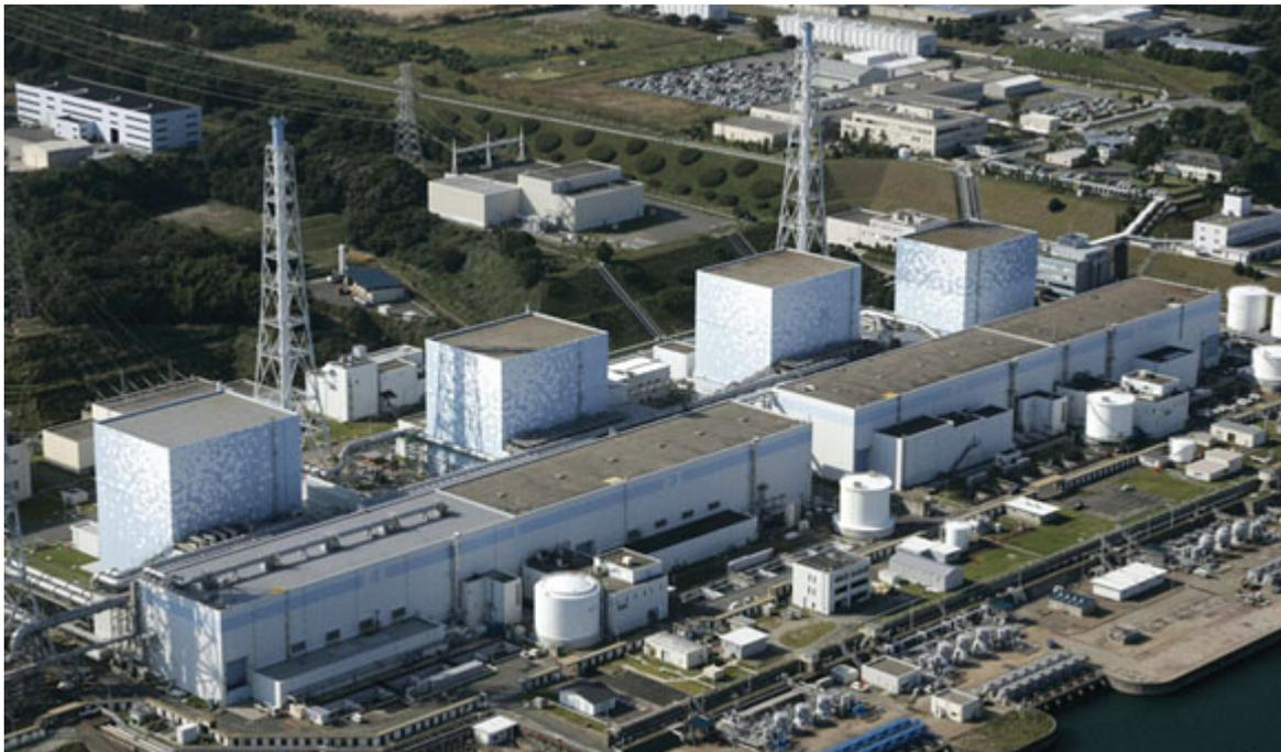
La centrale de Fukushima Daiichi est composée de 6 réacteurs nucléaires à eau bouillante construits entre 1967 et 1979, exploités par la multinationale Tokyo Electric Power Company (TEPCO).
