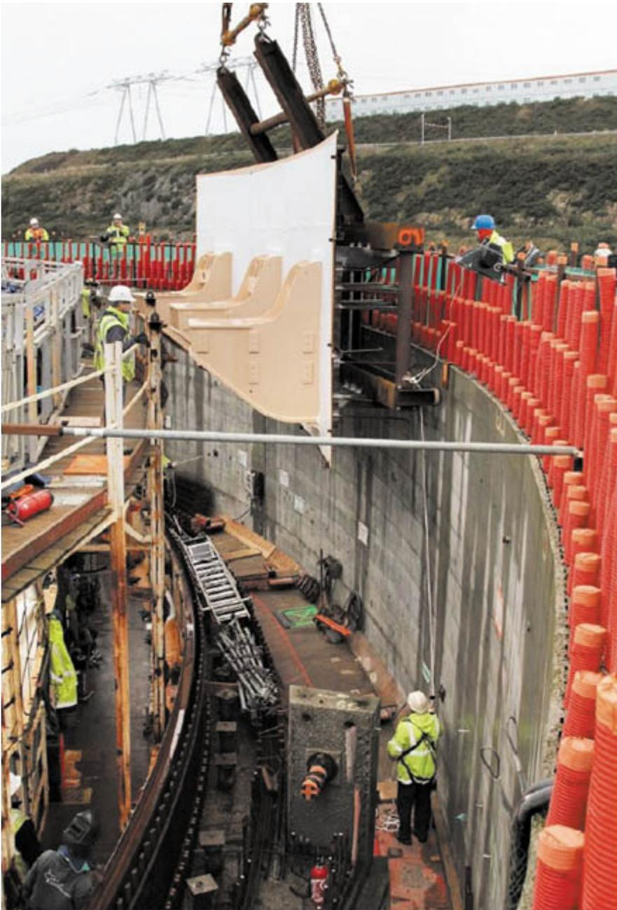
Mise en place de 3 consoles en acier de support du pont polaire. **Un chantier qui maltraite les travailleurs**
