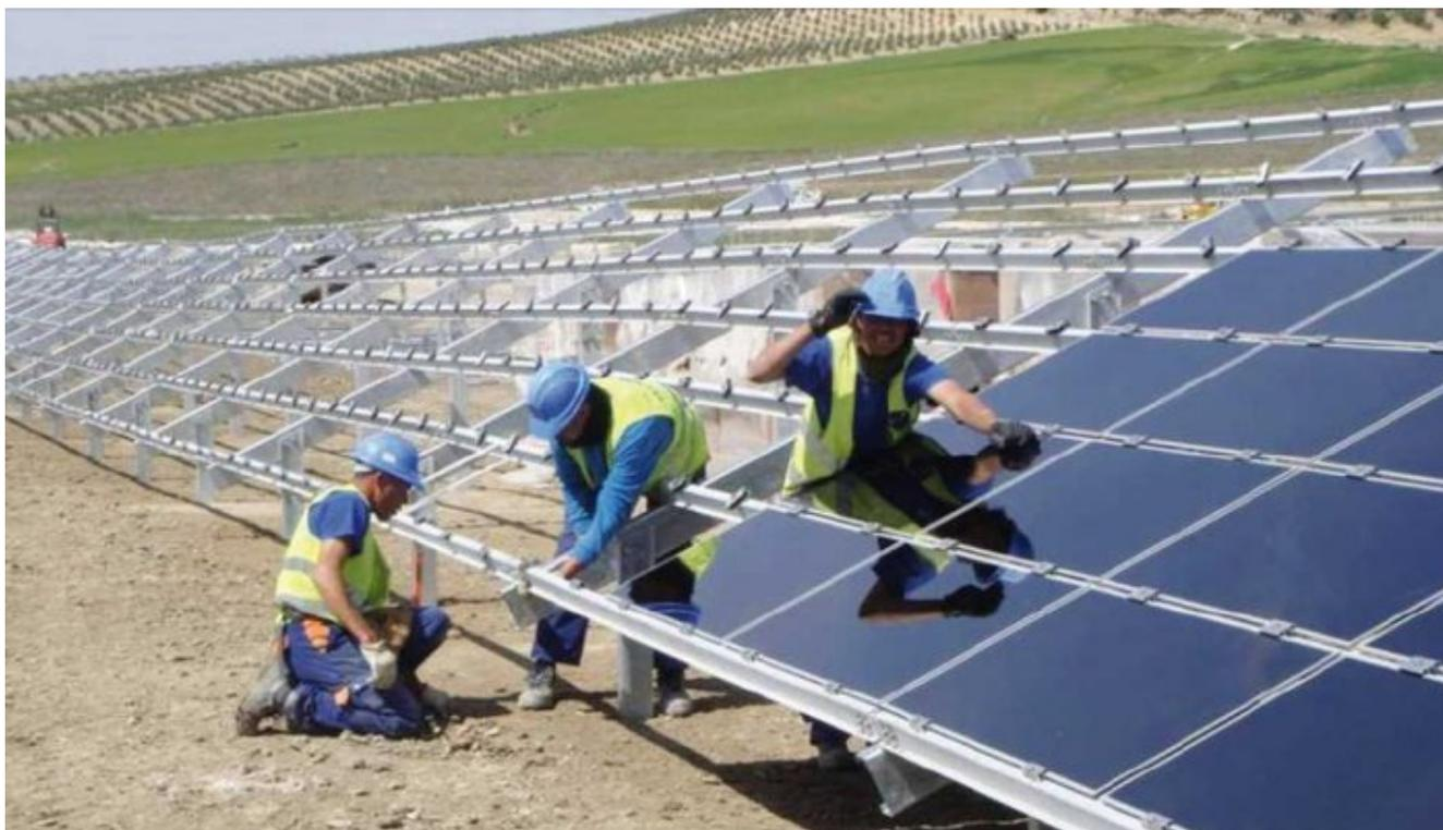
Des ouvriers installent des panneaux photovoltaïques d'une centrale solaire en construction dans la province de Paysandú.
