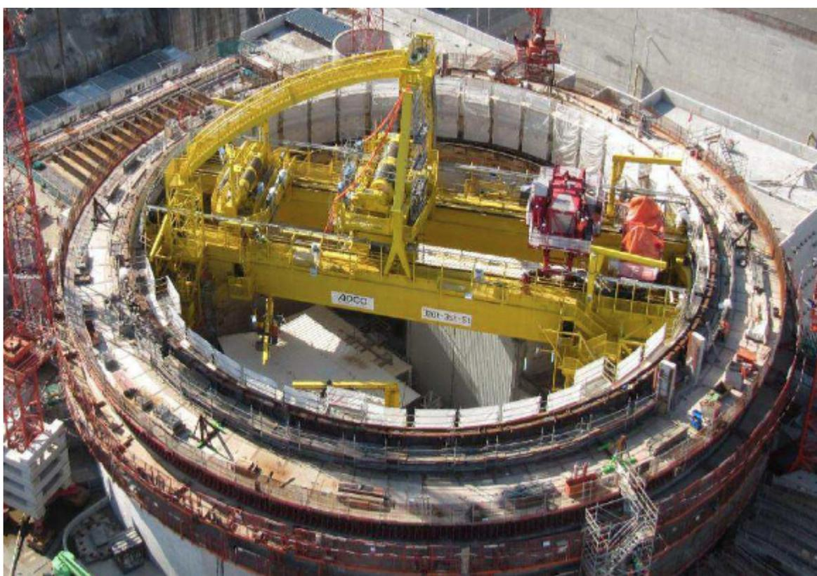
Aperçu du pont polaire (machine jaune) du réacteur EPR de Flamanville
