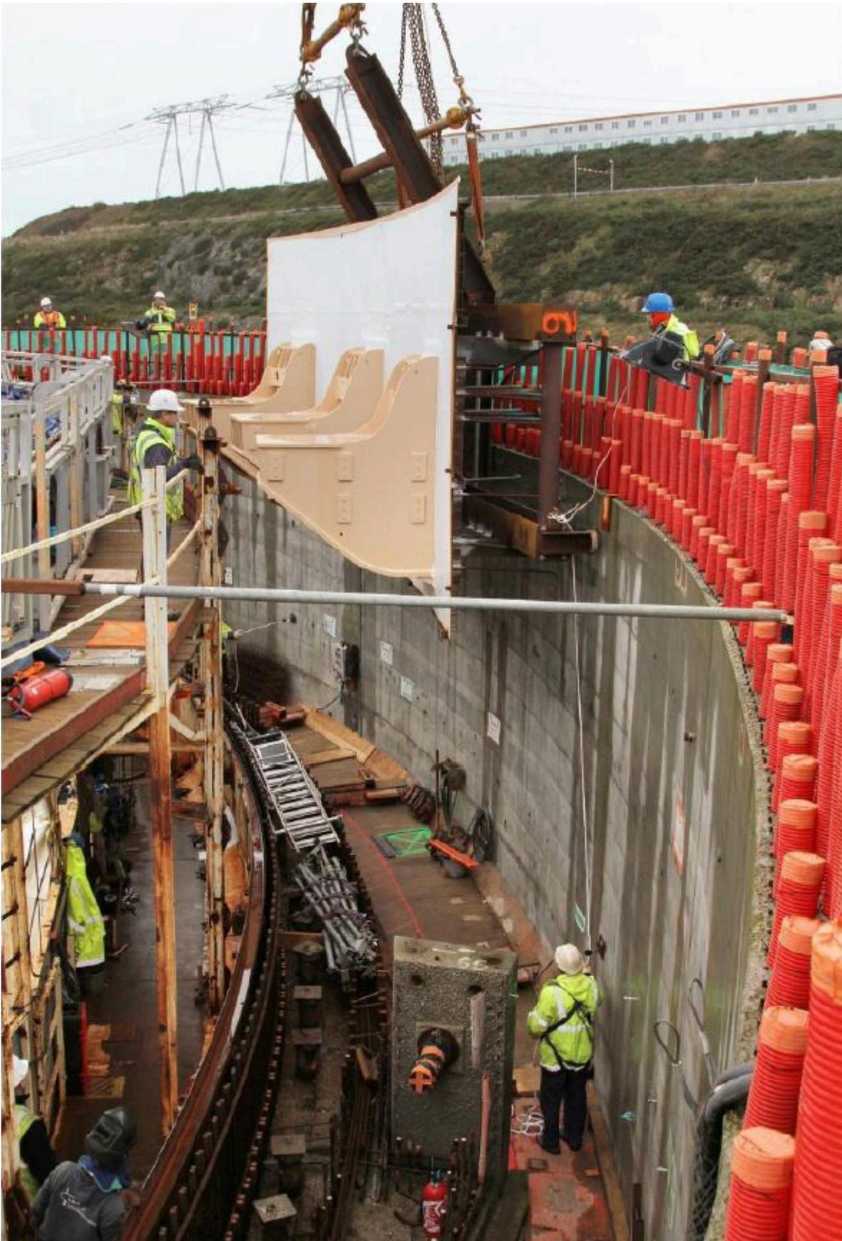
*Mise en place de 3 consoles en acier de support du pont polaire*
