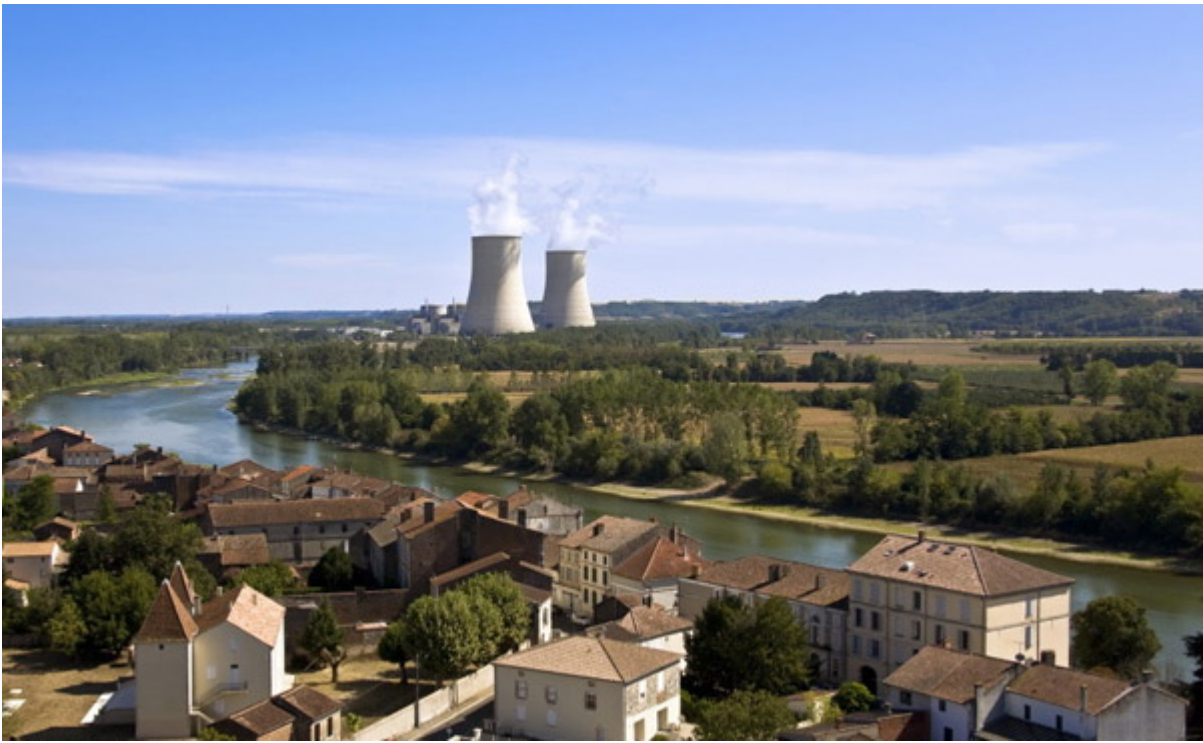
La centrale de Golfech (© EDF 2013)
