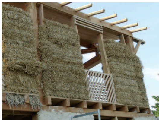
Les bottes sont ensuite recouvertes d'enduits de terre ou de chaux.
