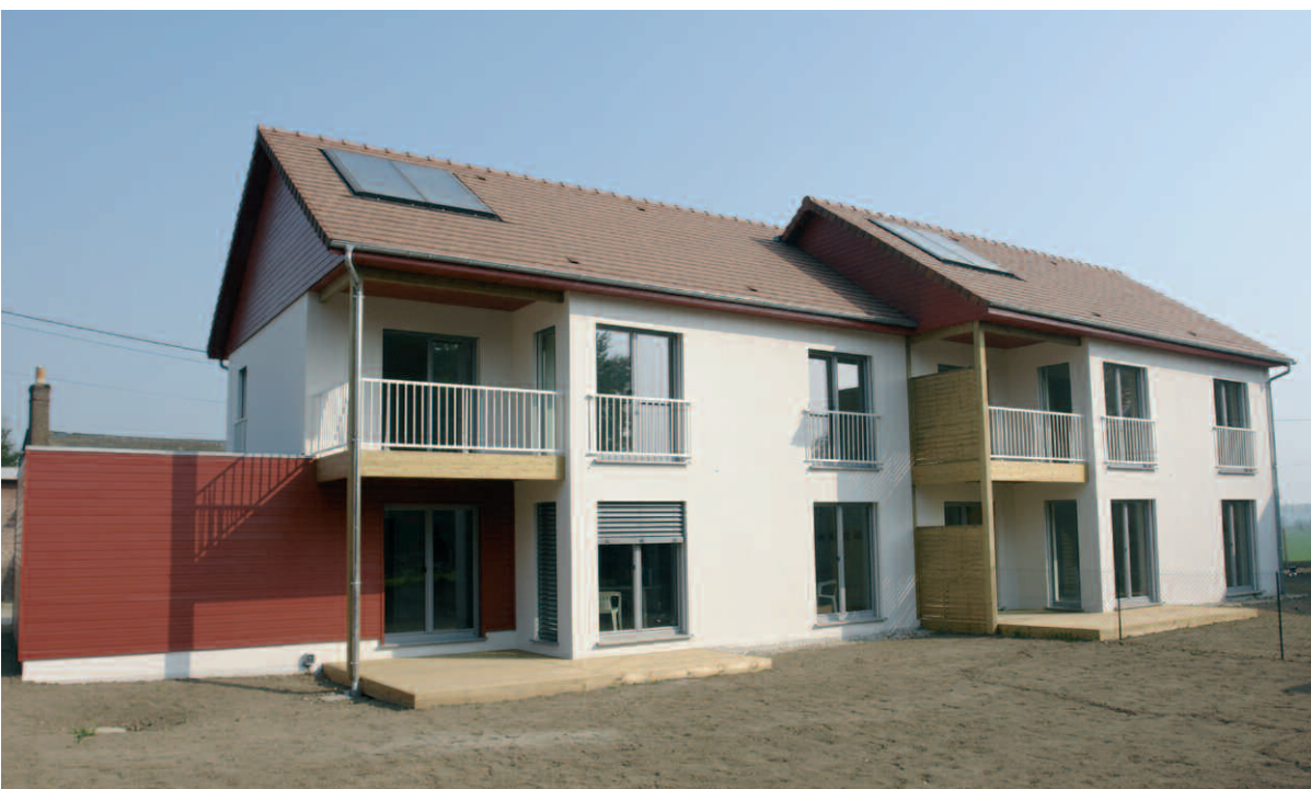
Les deux premières maisons passives labellisées françaises. Elles sont à Formerie dans l'Oise et cherchent d'heureux acquéreurs. Parfaitement isolées et ventilées, les besoins en chauffage sont minimes (moins de 15 kWh/m²/an). Une VMC double-flux avec récupérateur de chaleur suffit (système Viessman Vito-tres 343 couplé à un puits canadien). Réalisation Les Airelles.
