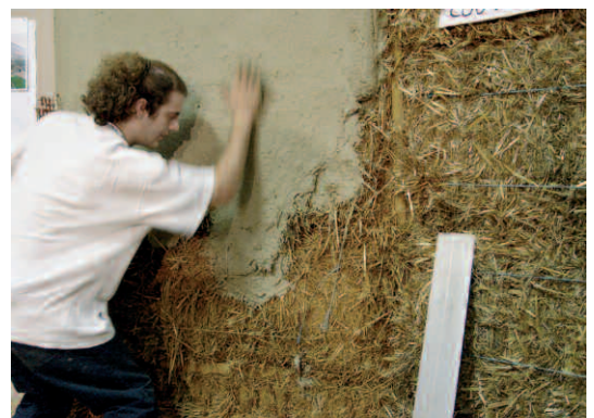
Les bottes sont ensuite recouvertes d'enduits de terre ou de chaux.
