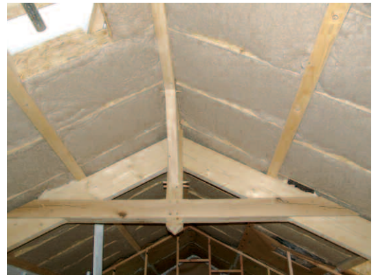
L'intérieur de la même maison : l'isolation a été réalisée en chanvre.
