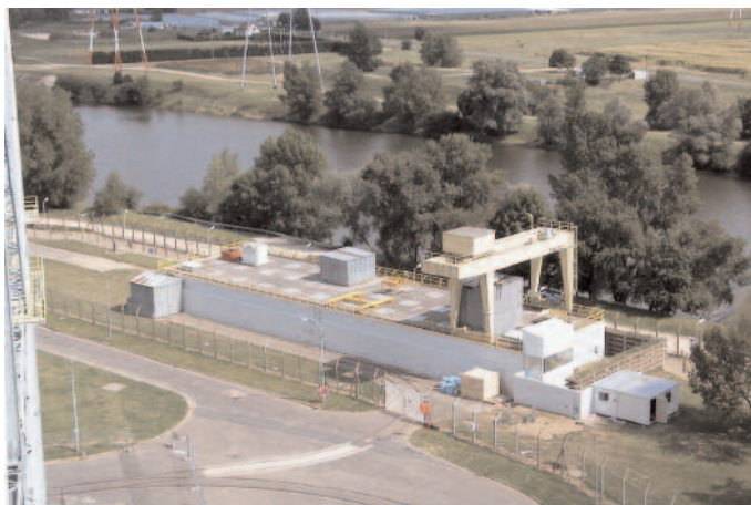
Silos de chemises de graphite de Saint Laurent des Eaux (Photo : CB)
