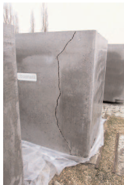
Coque béton fibre cubique (CBF-K) fissurée, démantèlement UNGG (Photo : CB)
