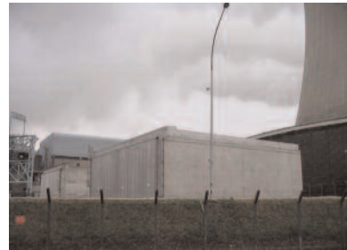
Bâtiment de stockage des générateurs de vapeur, centrale de Saint Laurent des Eaux (Photo : NP)
