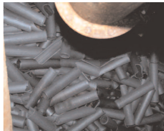
Intérieur d'un des silos de chemises de graphite de Saint Laurent des Eaux (Photo : CB)
