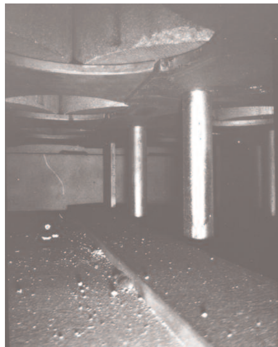
Contamination (« billes » brillantes) par de l'uranium irradié suite à la fusion d'éléments combustible en réacteur, vue sous la protection biologique de graphite (Photo : RE)
