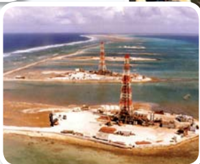
Chantier de forage au sol
