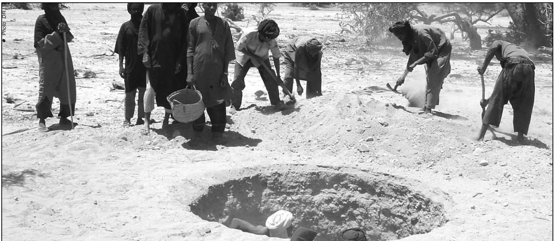
Les travaux HIMO sur un site d'intervention de l'ONG HED TAMAT
