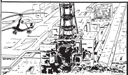
LE RÉACTEUR N'4 DE LA CENTRALE ATOMIQUE DE TCHERNOBYL N'ÉTAIT EN SERVICE QUE DEPUIS 4 MOIS LORSQU'IL EXPLOSA LE 26 AVRIL 1986. UNE EXPÉRIENCE DÉLICATE ET MAL PRÉPARÉE, LA CONFIGURATION DES RÉACTEURS RBMK SOVIÉTIQUES SOURCE DE DANGERS, ET DES ÉQUIPEMENTS ÉLECTRIQUES MANQUANTS MALGRÉ LA MISE EN SERVICE, PAR CONTRAINTE BUREAUCRATIQUE EXPLIQUÈRENT LES CONDITIONS QUI CONDUISIRENT À LA PLUS GRANDE CATASTROPHE TECHNOLOGIQUE DE L'HISTOIRE.
