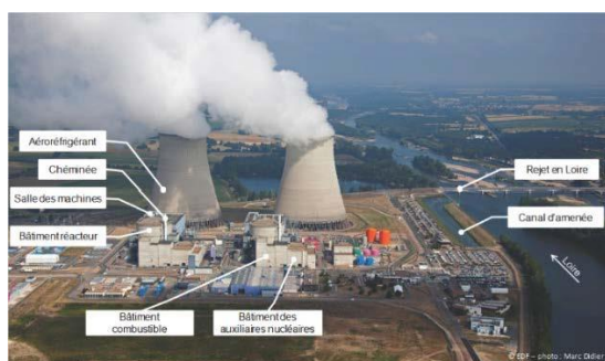
Figure 1 : Vue générale de la centrale de Belleville (source : dossier)
